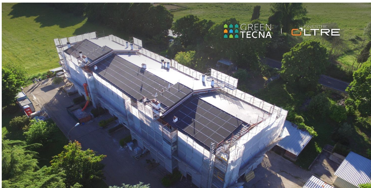
Fig. 4.1: Condominio "La Mimosa" situato nel Comune di Bassano Romano (VT), riqualificato grazie ai lavori del Superbonus 110% con l'installazione delle Finestre OLTRE.
