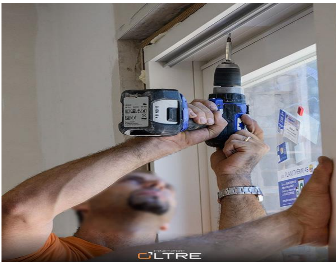
Fig. 3.5: Installatori DEAR in cantiere specializzati nella posa ad alta efficienza termoacustica
