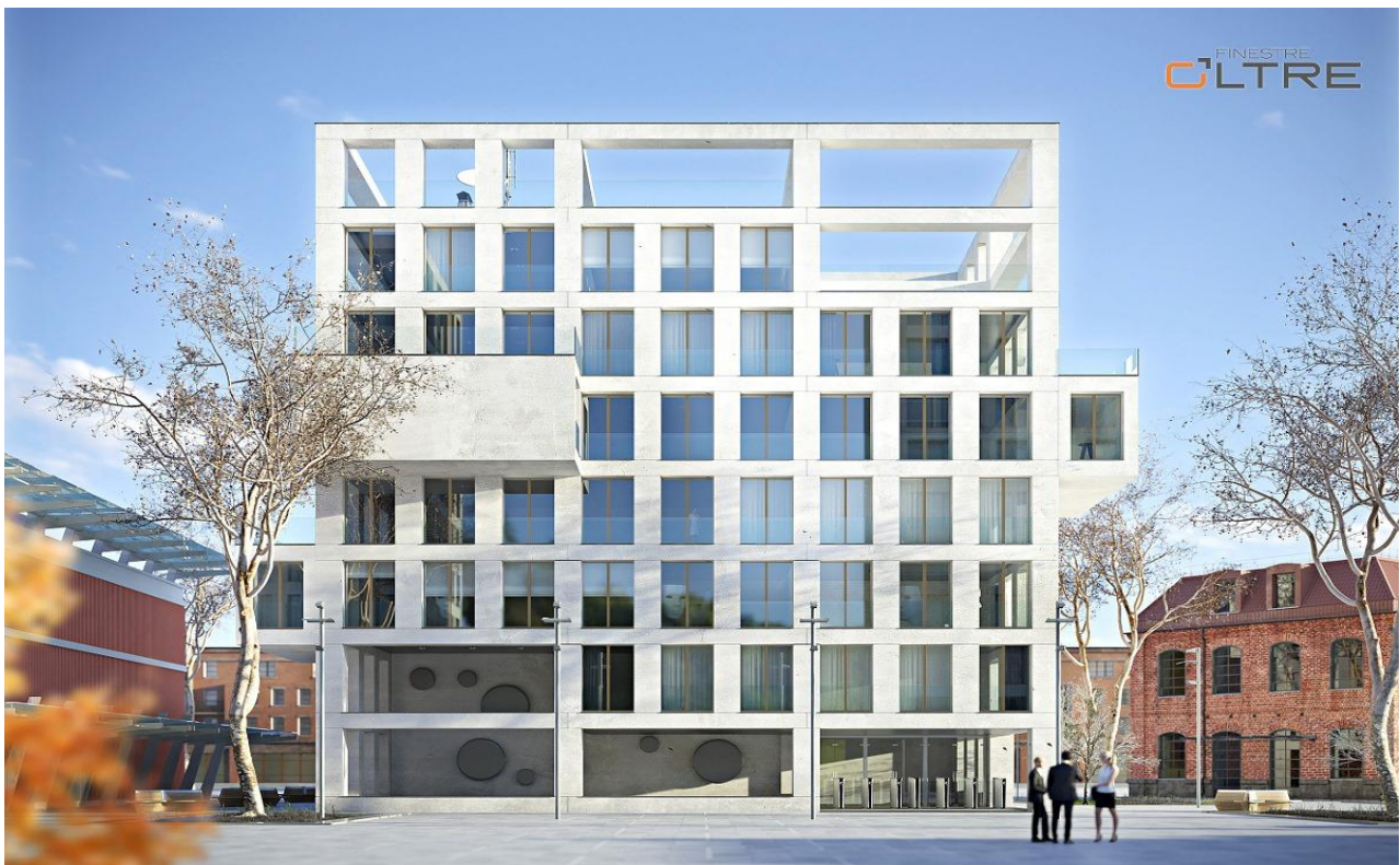
Fig.1: Edificio dallo stile architettonico moderno, minimale e a basso consumo energetico.
